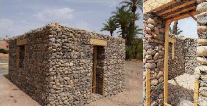
الشكل 14: بناء البيوت بشبكات من الأسلاك مليئة بالحجارة الطبيعية
